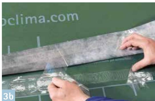
Verklebung der Bahnenüberlappung bei INTESANA connect mit den zwei integrierten Selbstklebezonen. Verklebung fest anreiben (PRESSFIX).
