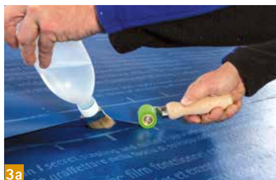
WELDANO TURGA Verschweißt SOLITEX WELDANO 3000 homogen und sicher miteinander
