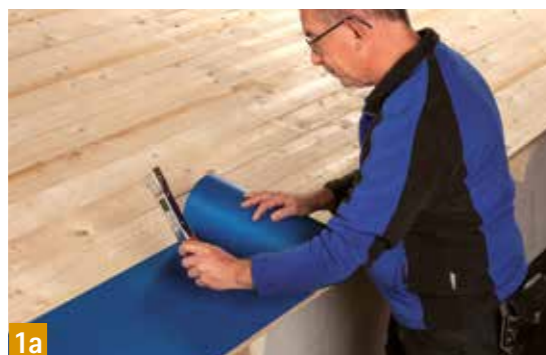
SOLITEX WELDANO-S 3000 Dichtet diffusionsoffen und homogen verschweißbar ab
