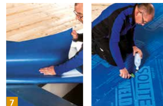
ORCON CLASSIC Schliesst SOLITEX WELDANO 3000 an glatte und raue angrenzende Untergründe an
